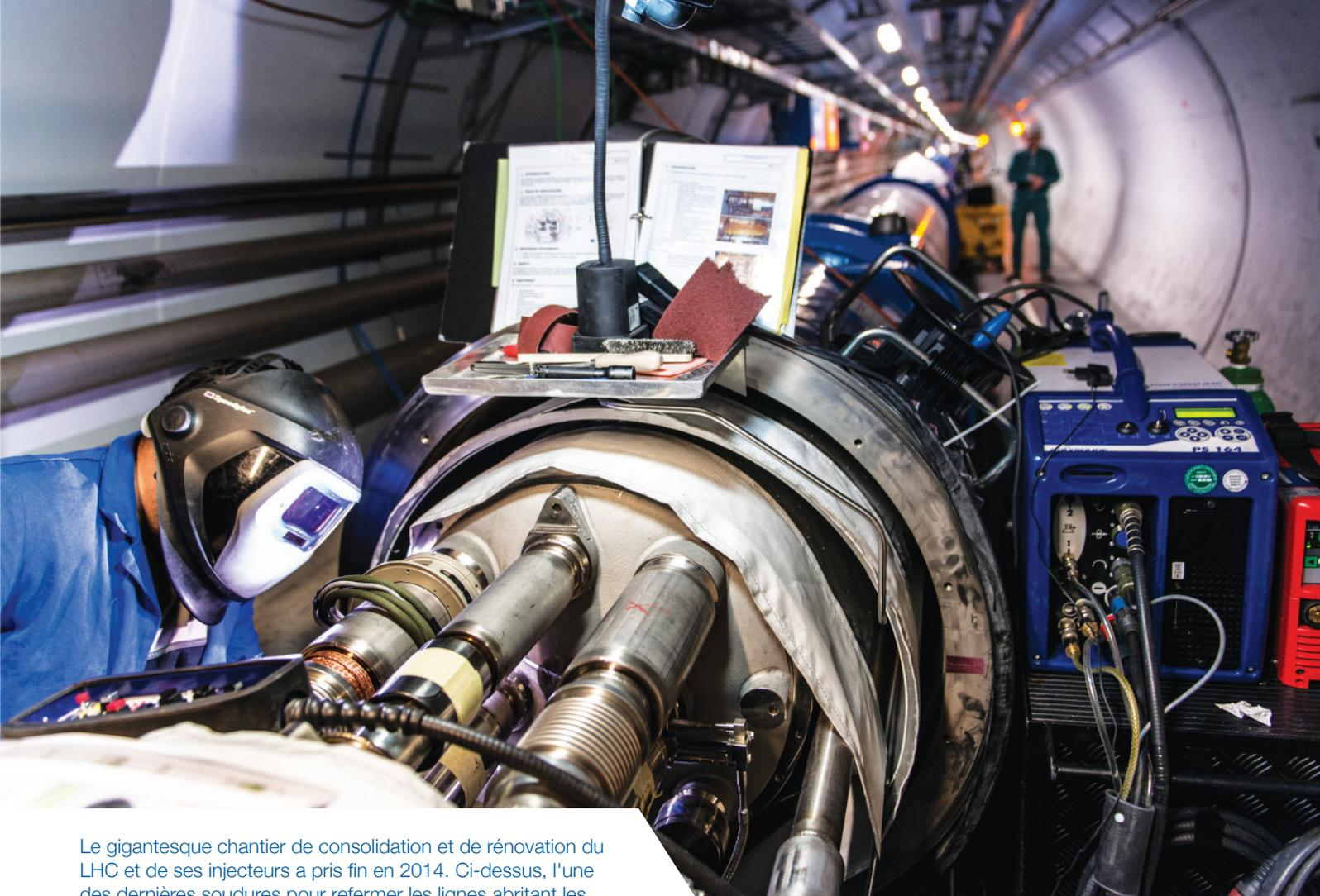
Le gigantesque chantier de consolidation et de rénovation du LHC et de ses injecteurs a pris fin en 2014. Ci-dessus, l'une des dernières soudures pour refermer les lignes abritant les interconnexions entre les aimants supraconducteurs. (CERN-PHOTO-201404-084 – 7)
